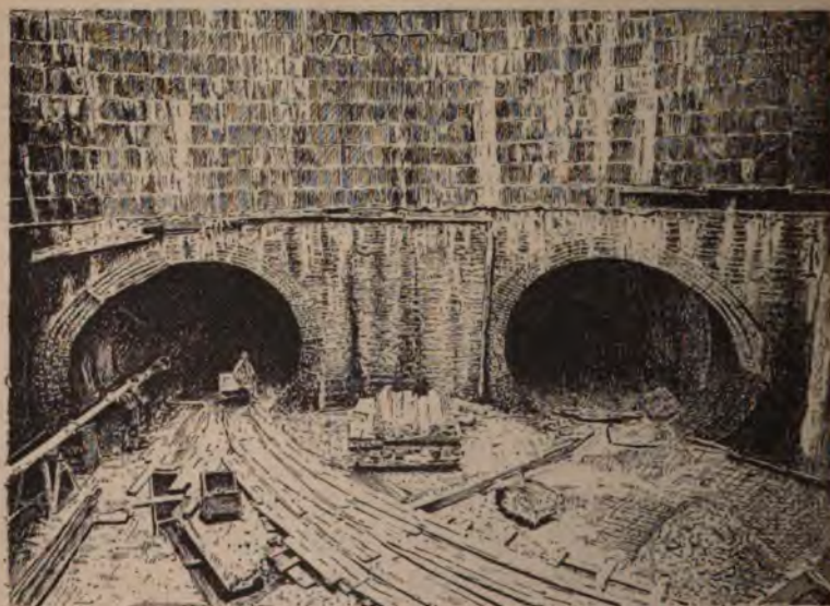
Fig. 130. — Entrée des souterrains.
